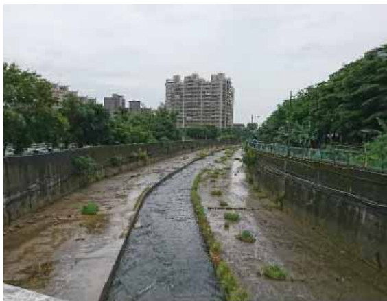
大窠坑整治前
