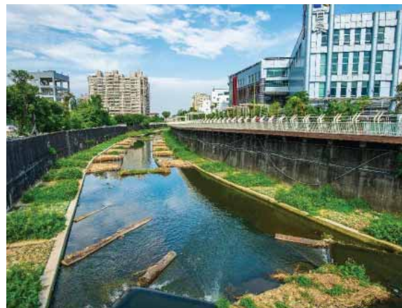
大窠坑溪整治第一期工程整治後現況
