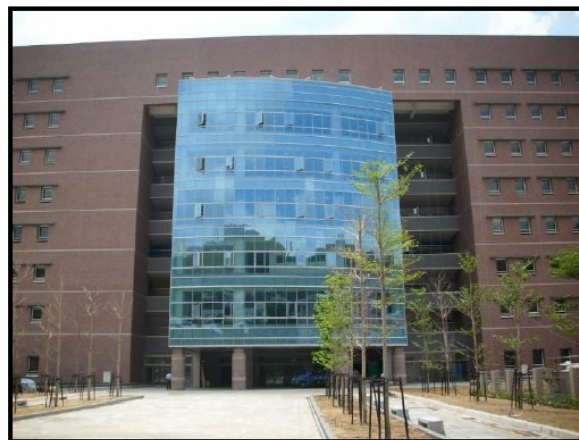
原南亞公司舊廠區(棕色地帶)改建為創新大樓
