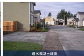
透水混凝土鋪面
